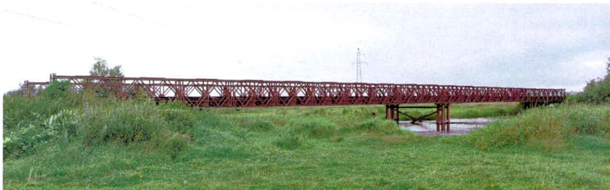
Widok ogólny mostu od dolnej wody
